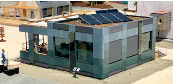
Figuur 3: Het MOR-paviljoen op de Solar Decathlon 2019 in Szentendre, Hongarije: een uitsnede van een van de Marcocintorens in Rotterdam, dat van een leegstaand, energetisch inefficiënt kantoor is getransformeerd naar een duurzaam woongebouw [foto: auteur]
